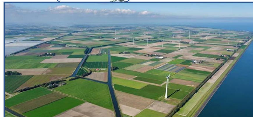
De 11 kilometer lange, kaarsrechte Wieringermeerdijk met het windpark nog in aanbouw
