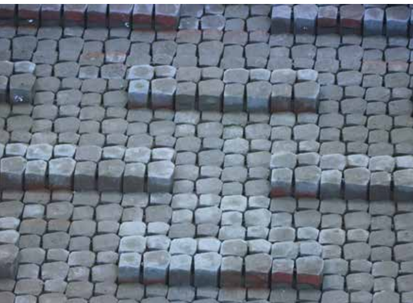
Quattroblokken met verschillende zuilhoogten.
